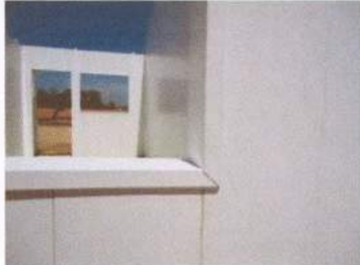
Figura 20 – Abertura das janelas com acabamentos em PVC
