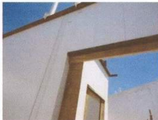
Figura 16 – Escoramento de aberturas de portas para concretagem
