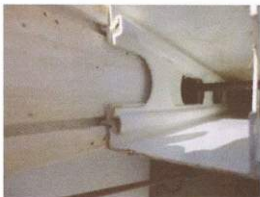
Figura 15 – Ferragem posicionada na região da contra-verga
