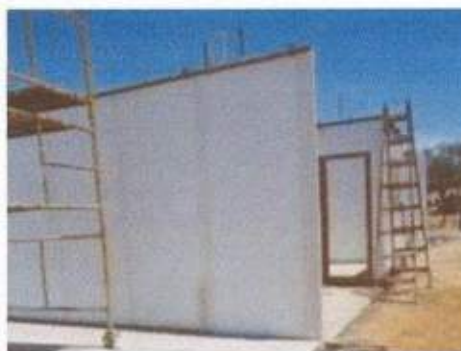
Figura 14 – Painéis de PVC posicionados e escorados
