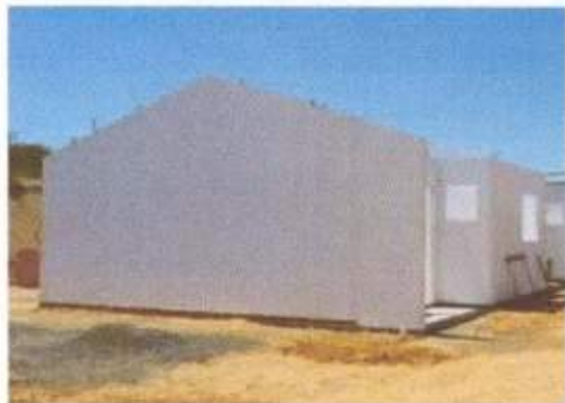
Figura 19 – Painéis de PVC concretados
